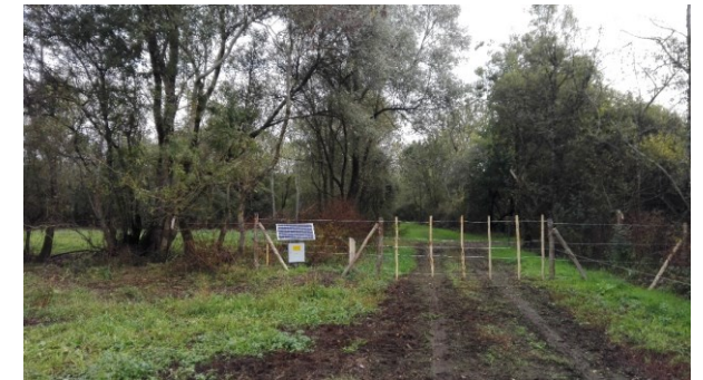
Batteries solaires, fils électriques, piquet et barrière agricole
