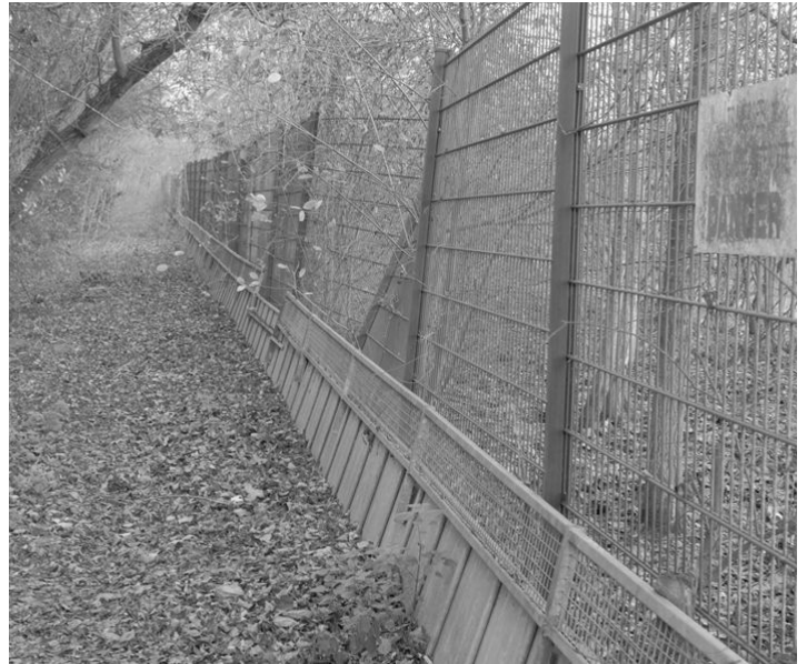
Dispositif de cloisonnement au parc du Sausset. En bas du grillage, des palplanches empêchant la circulation des lapins venant du talus RER.
